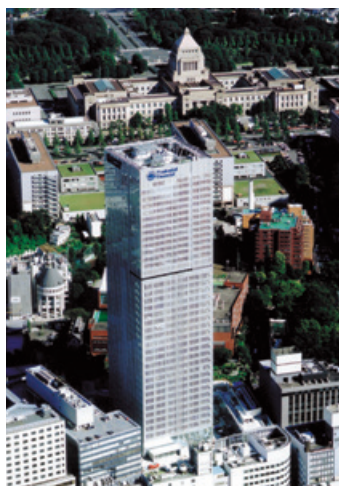
プルデンシャルタワー (東京・永田町)
