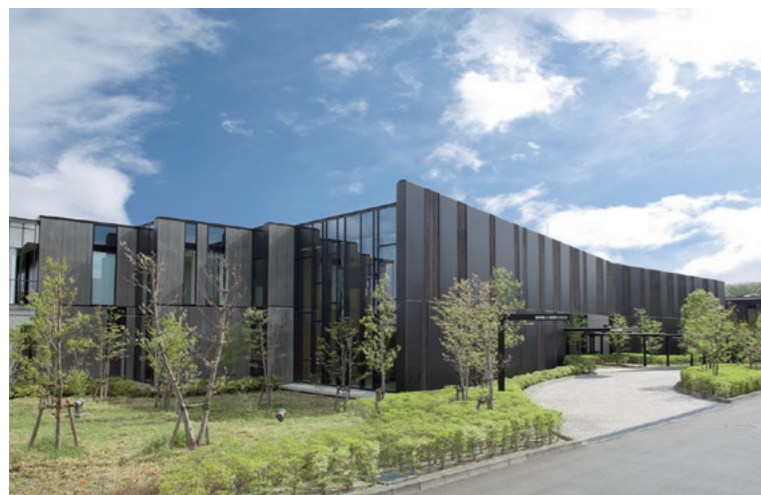
宮城・仙台 ドライデンカスタマーセンター
